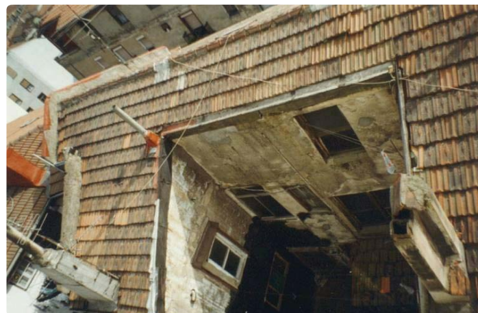
Krov objekta u razmatranju
