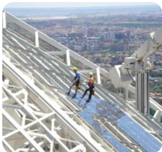
Cristal Tower MARTIFER SOLAR SA
